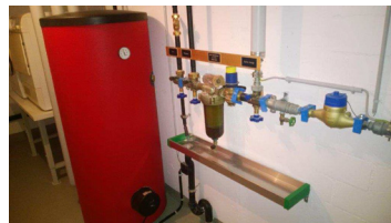
Das Dienstleistungsangebot der von Euw AG Heizungen umfasst sämtliche Bereiche rund um die Wärme.
